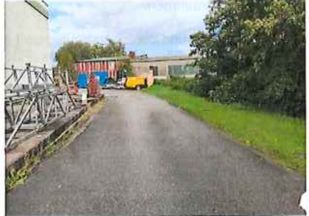
Abb. 6d Zufahrtbereich im Südosten des Plangebiets
