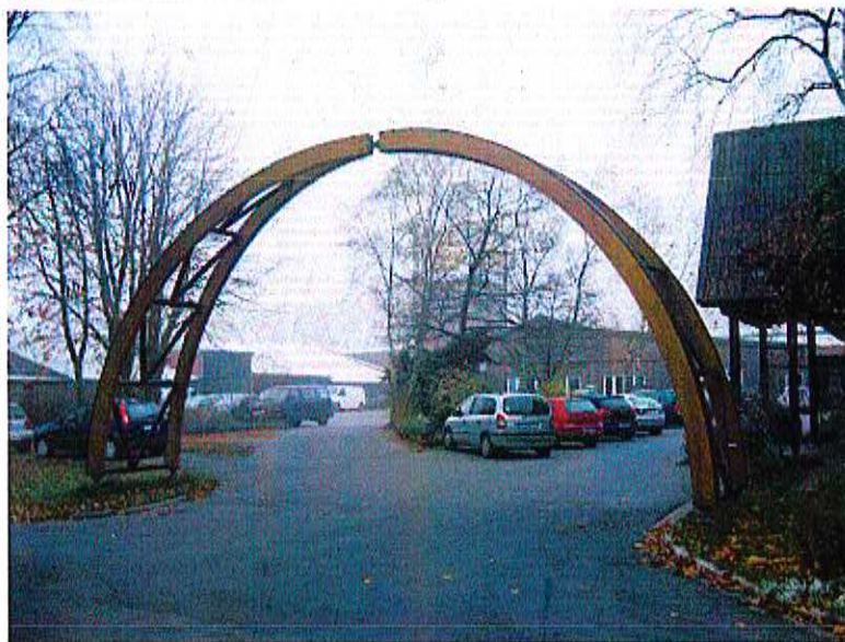
Abb.: Zufahrt zum Gewerbebetrieb von der Straße Am Bahnhof.
