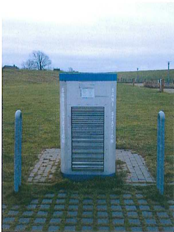
Abb. 3 Blick auf die vorhandene „Sanistation“ zur Entsorgung von Chemietoiletten; auf der Rückseite besteht eine Wasserzapfstelle (P. Scharlibbe 02.12.2011)
