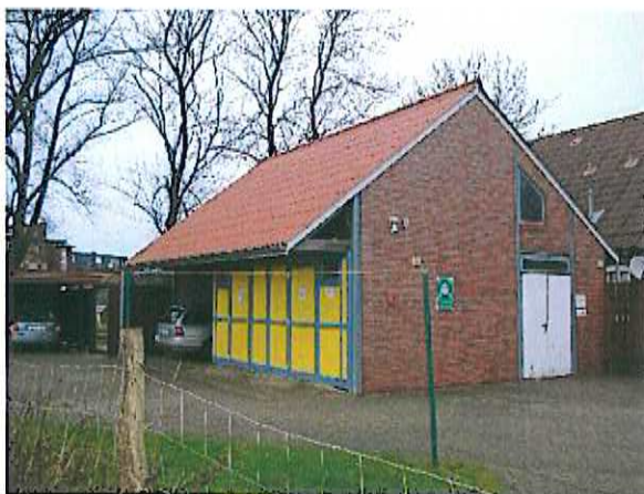
Abb. 5 Blick auf das bestehende Sanitärgebäude (P. Scharlibbe 02.12.2011)
